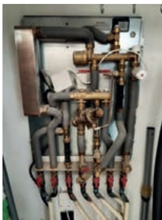
Module Thermique d'Alimentation avec l'échangeur à plaques à gauche.
