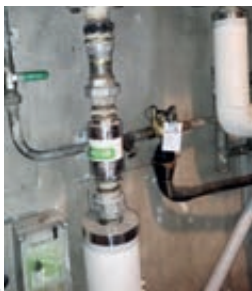
Pose d'un Anticalcaire Drag'Eau EF-i50 en octobre 2022.
