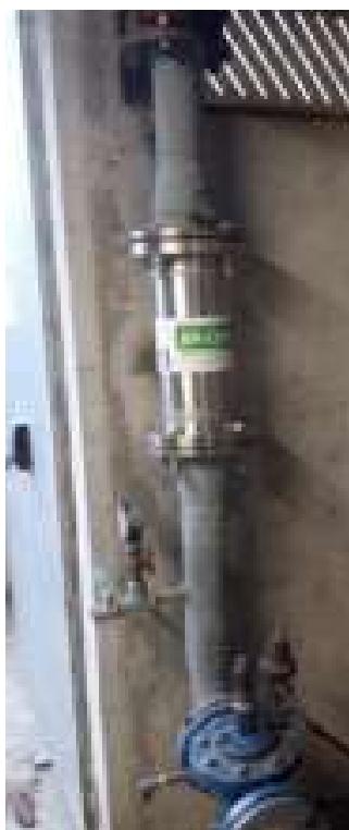
EF-i100 et EF-i50 installés sur Eau froide générale
